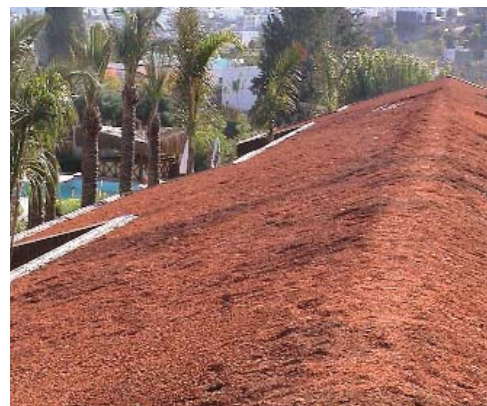
Grancha Sağlık Tesisleri / Bodrum
