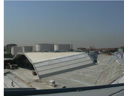
Metro Gross Market Şantiyesi / Ümraniye-İstanbul
